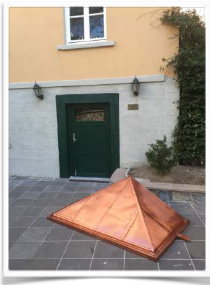
Det nya taket över entrén till auditoriet, före ...
