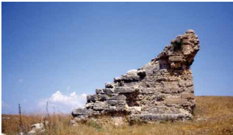
Fig. 2. Kortändan av en läktare med spår av borttagna marmorplattor. Stadion i Mopsuestia i östra Kilikien, synligt för såväl tågresenärerna på Bagdadbanan som bilisterna på E5/E24 men praktiskt taget okänt (foto författaren).
