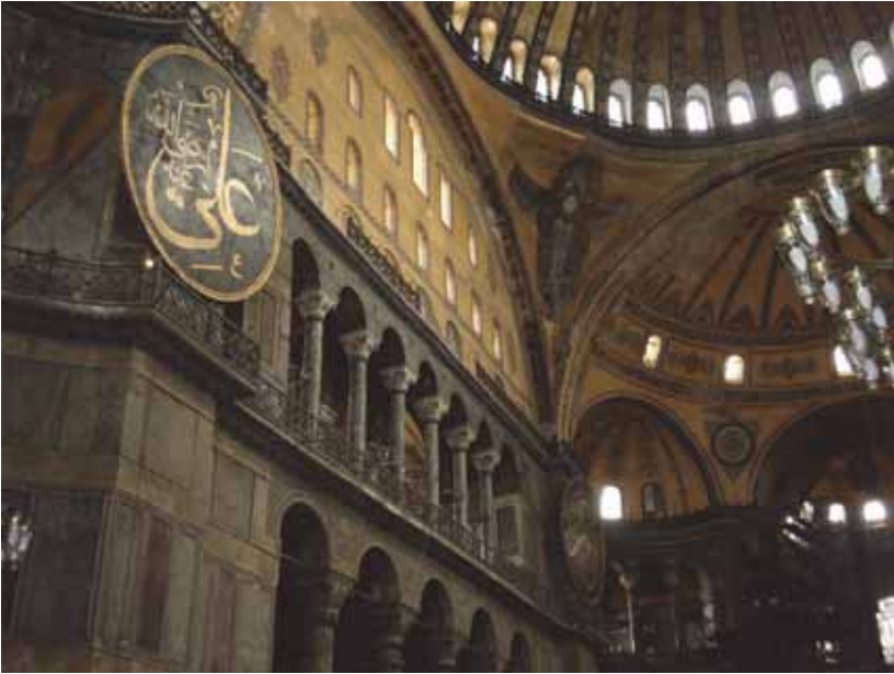
Fyra valvbågar bildar den kvadratiske basen i kyrkan. Östra valvet är öppet mot absiden. Det norra utgör en vägg som genombryts av fönster och sidogallerier. Kalifen Ali hedras genom det medaljongformade konstverk, som kalligrafiskt återger hans namn. (Foto: förf.).
