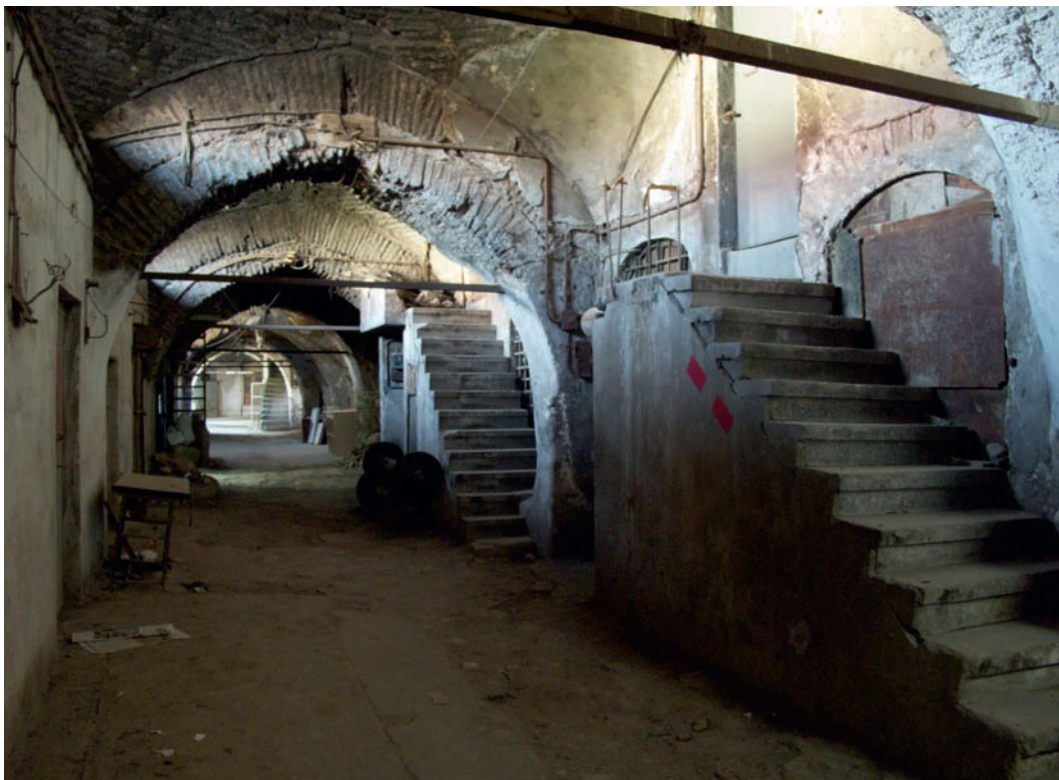
Gången en trappa upp med sina förfallna valv och kupoltak måste en gång varit anläggningens pulsåder, ett slags inbyggd huvudgata. Foto Catharina Gabriellsson.
