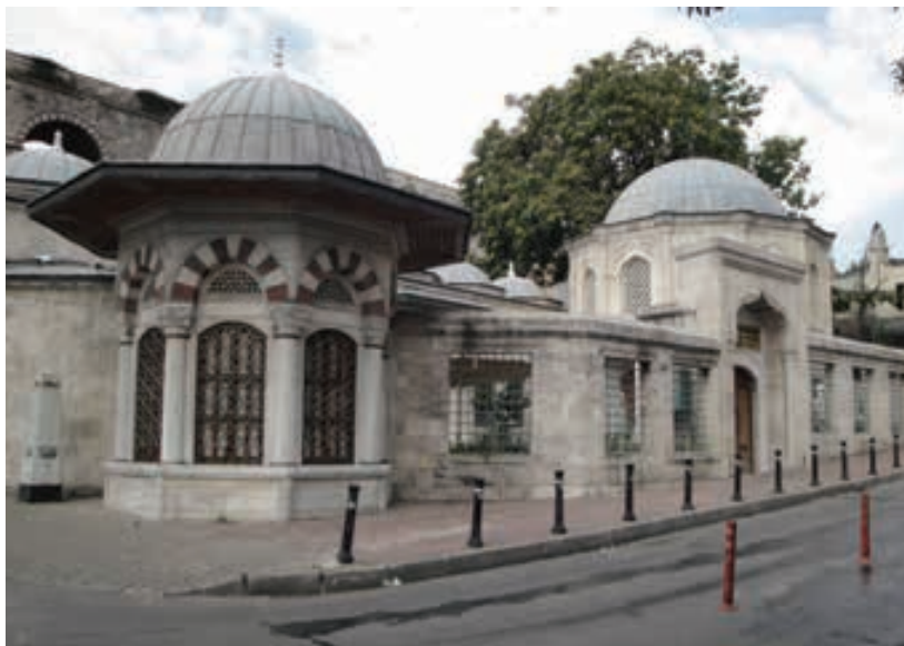
Gazanfer Aghas madrasa vid Valensakveduktens norrsida, med mausoleet och vattenkiosken närmast stråket. Foto författaren
