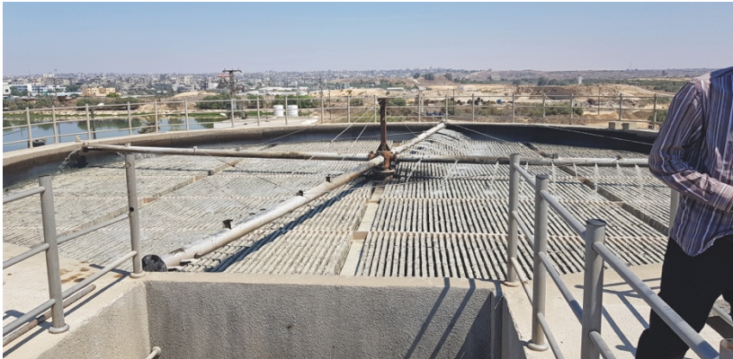
Utsikt över Rafah från toppen på kommunens vattenreningsanläggning. Foto Raed Bashithalshaaer.
